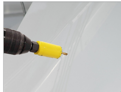
[Kuva 13] Poraa 22mm reikä kaapelien läpivientiä varten
